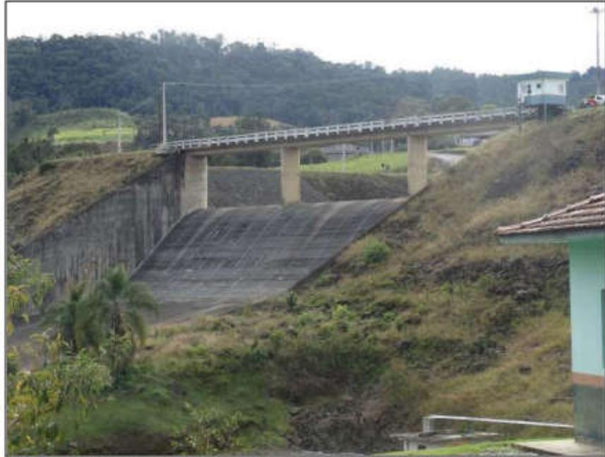
Figura 1: Vista a jusante do vertedouro da barragem. Paramentos apresentando arbustos e pedras do enrocamento expostas
