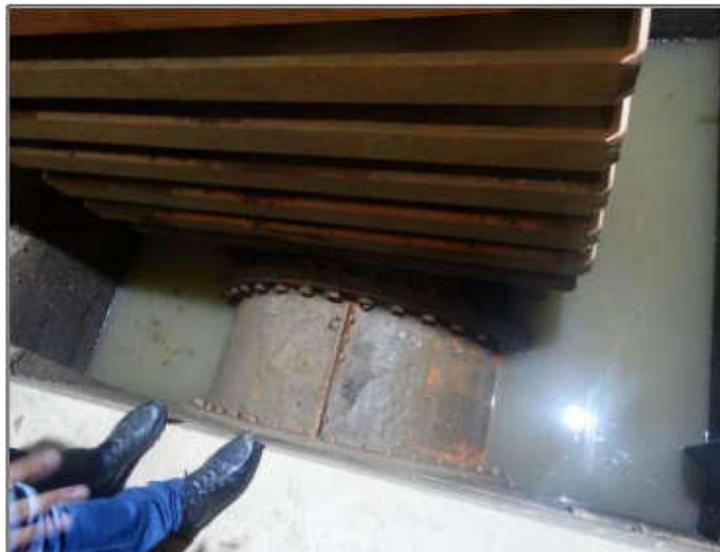
Figura 3: Trecho do conduto a montante da comporta apresentando vazamento de água.
