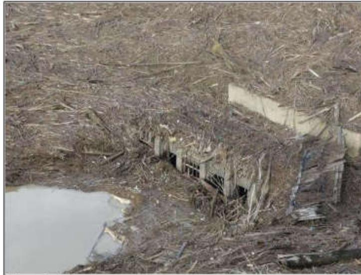
Figura 2: Entrada dos descarregadores de fundo desprotegido de grade e apresentando assoreamento no seu perfil
